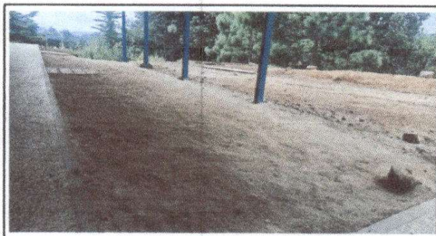
Foto 4: Reparación de planchas de concreto de patio
