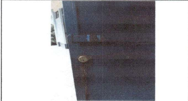
Foto1: Sustitucion de chapa
