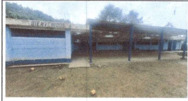
Foto 2: Pintura en muros exteriores e interiores
